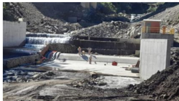
Obras civiles del proyectoMHE, La Paz.
