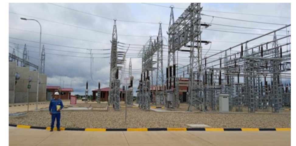
Sitio de construcción de la Bahía de Transformador 115 kV - Subestación Paraíso
